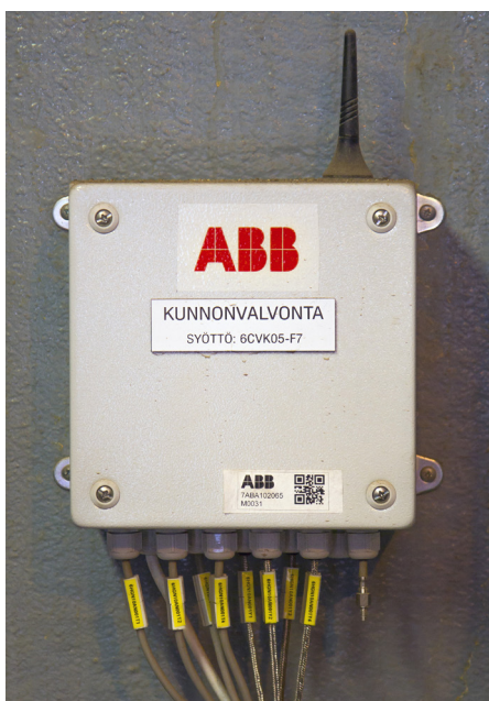
Itsenäinen langaton tiedonkeruujärjestelmä kerää kriittistä tietoa koneista- ja laitteista.
